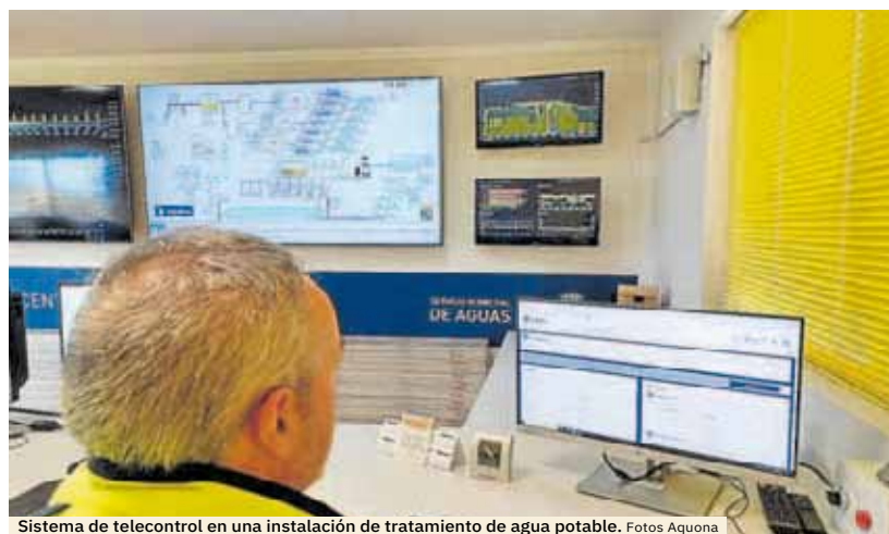
Sistema de telecontrol en una instalación de tratamiento de agua potable. Fotos Aquona
