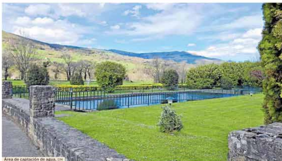
Área de captación de agua. DM
