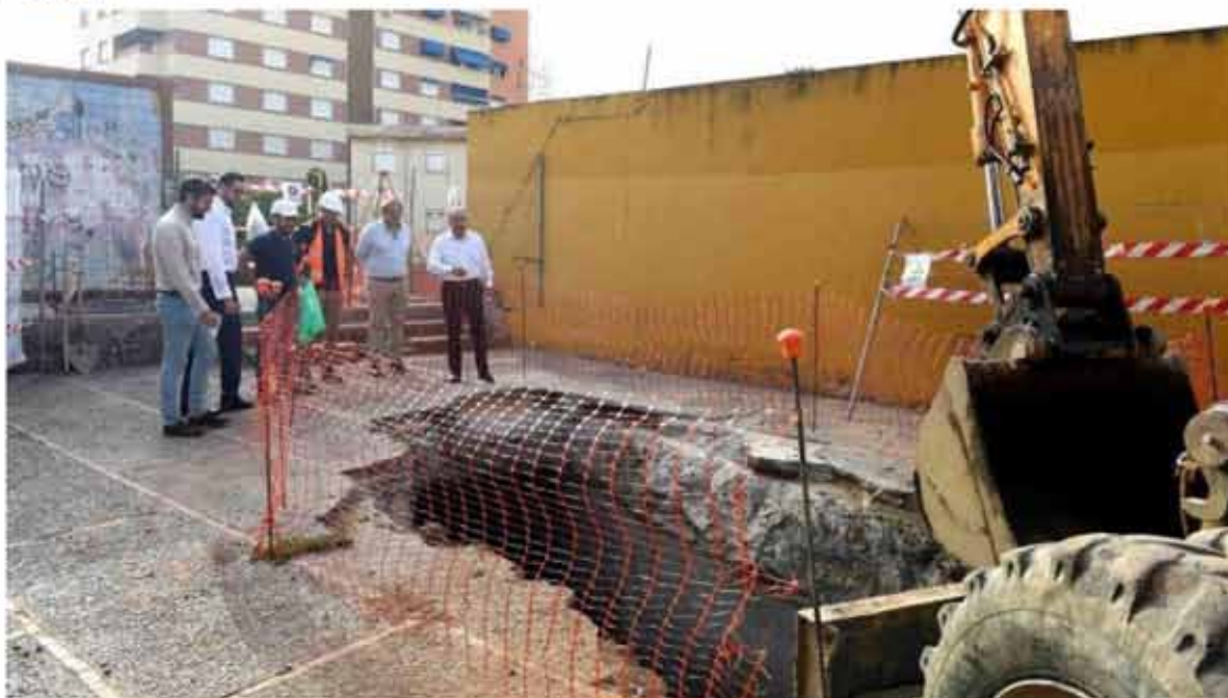
Obras hidráulicas en Algeciras. / FOTO: AAM
