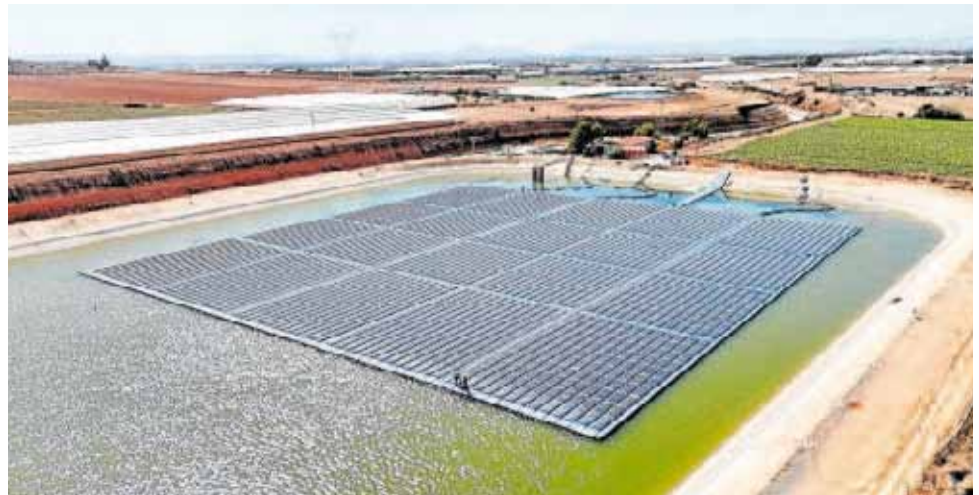
Cubierta fotovoltaica flotante con 2.340 paneles solares en Torre Pacheco //COMUNIDAD REGANTES CAMPO CARTAGENA
