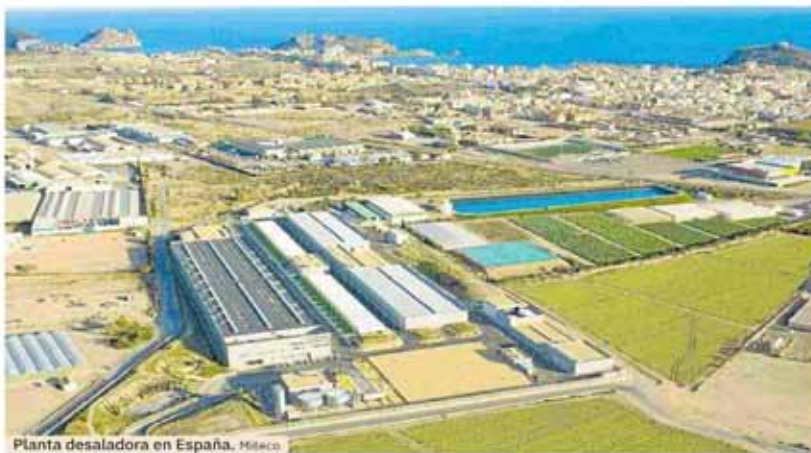
Planta desaladora en España, Miteco
