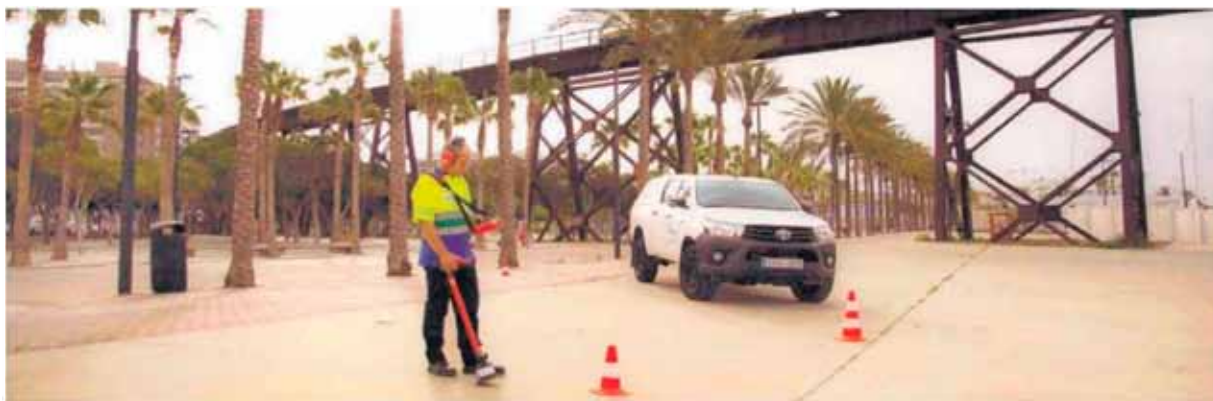
Un trabajador de Aqualia busca posibles roturas en la zona del Cable en Inglés en la capital.
