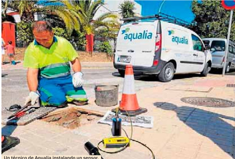
Un técnico de Aqualia instalando un sensor.
