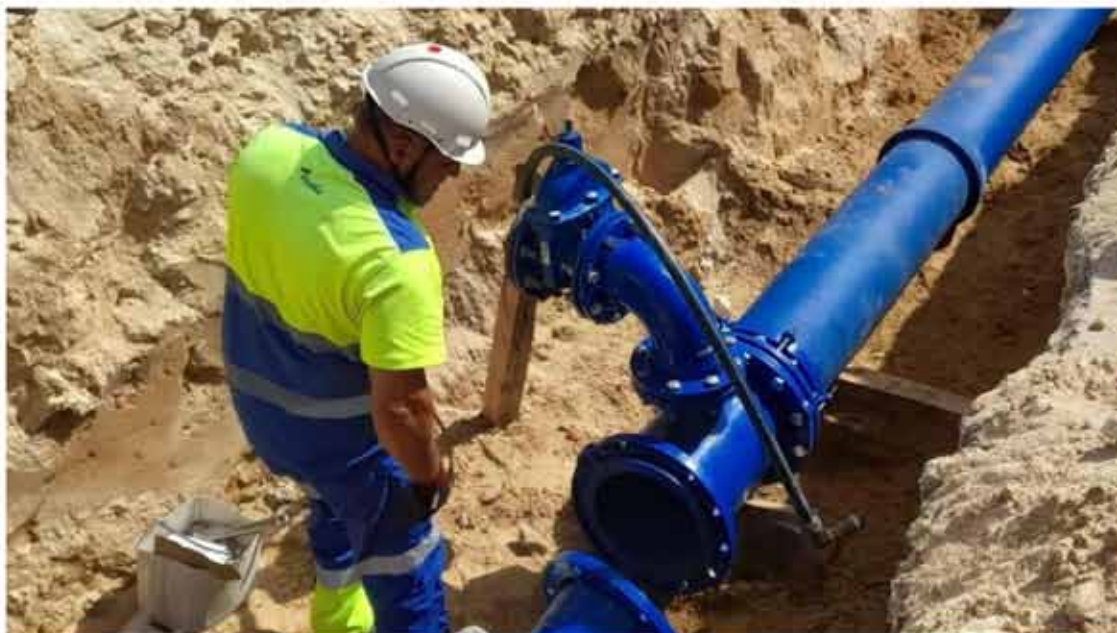
Un operario de Aqualia en la ejecución de una nueva red abastecimiento hídrico.
