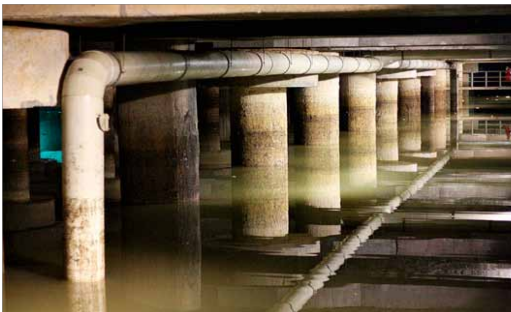
Estado actual del tanque de tormentas de Arroyofresno, el que más capacidad tiene en la región. FOTO: CANAL DE ISABEL II
