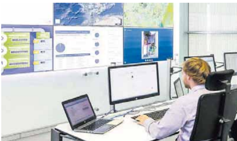
Pantallas del centro de control operativo de Aquara.
