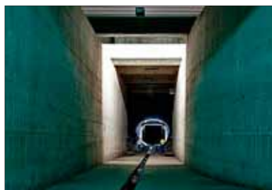
Colector de entrada al tanque de Arroyofresno. CANAL DE ISABEL II
